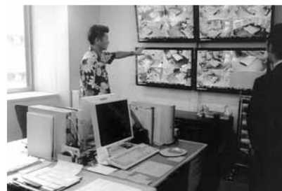
見守りモニター設置
