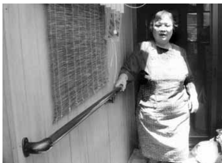
「手すり」を設置しました。
