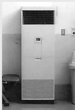
大型エアコン4台の入替え
