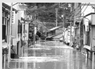
浸水した柚木商店街
